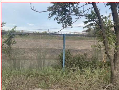
ภาพที่ 2.2-18 โครงสร้างเหล็กค้ำยันดักฝุ่น ล้อมรอบพื้นที่ลานกองเถ้า
