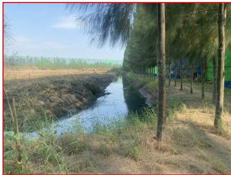
ภาพที่ 2.2-24 รางระบายน้ำรอบพื้นที่ลานกองขนถ่าย
